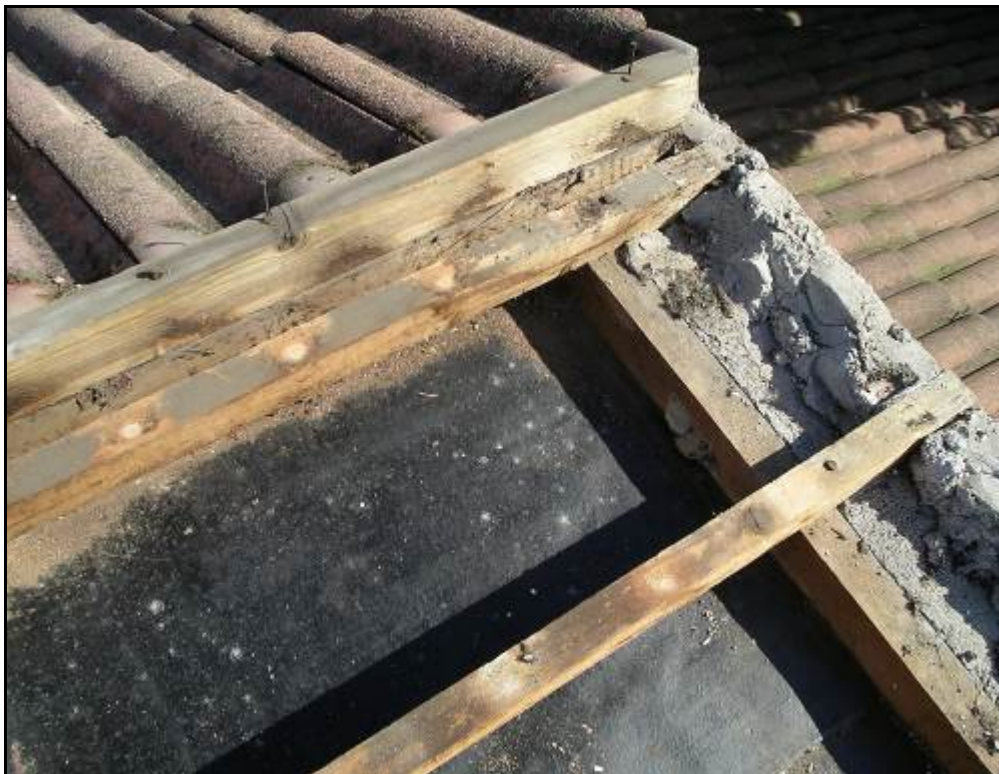
Figura 3: Copertura esistente – Dettaglio n° 1
