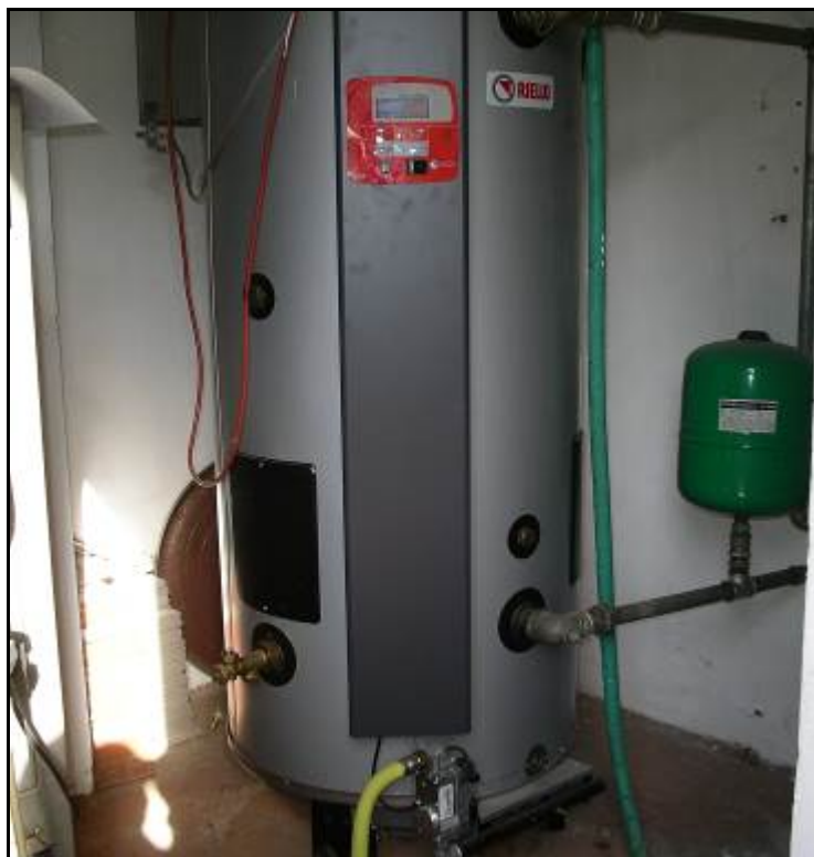
Figura 17: Sistema di produzione ACS
