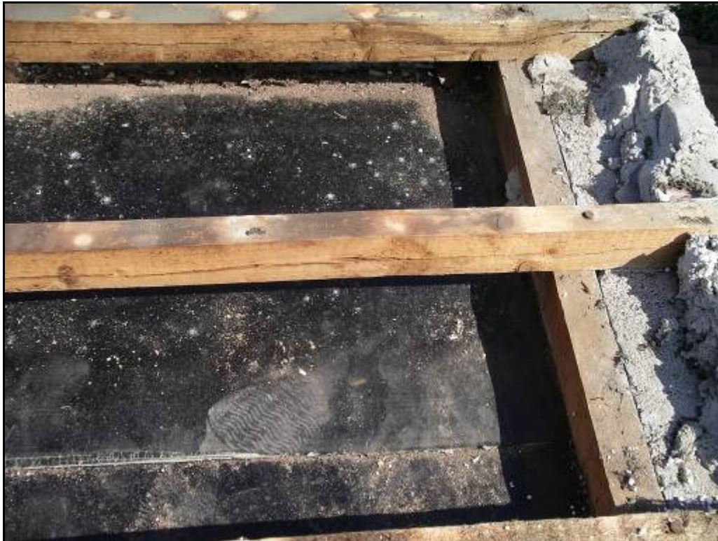
Figura 4: Copertura esistente – Dettaglio n° 2
