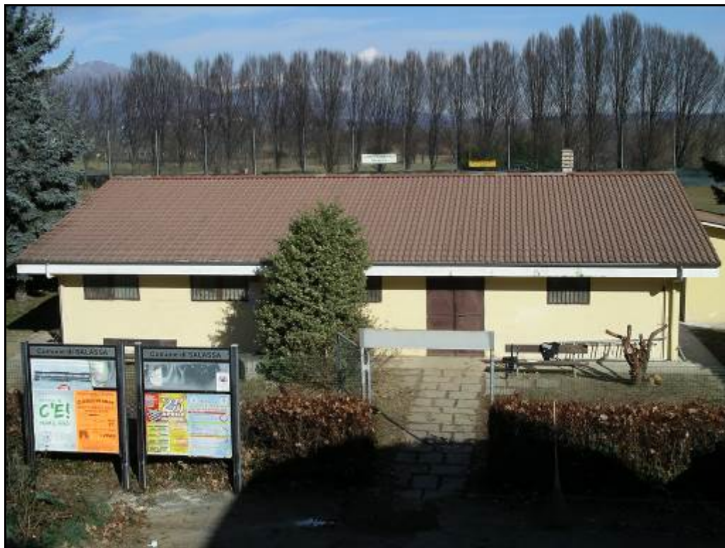
Figura 1: Sito di intervento
