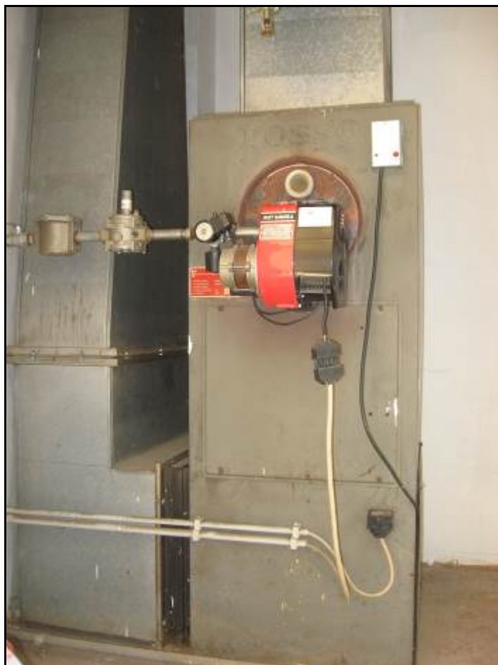
Figura 10: Generatore ad aria calda
