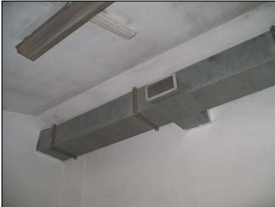
Figura 14: Dettaglio canalizzazione di distribuzione principale
