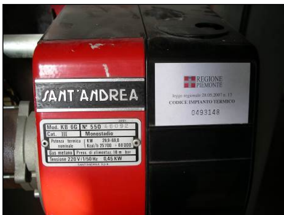
Figura 11: Dettaglio bruciatore
